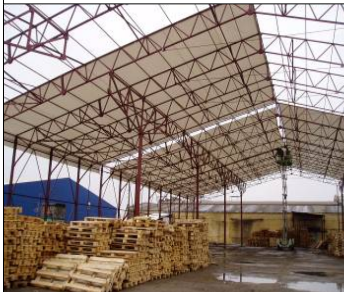
Каркасно-тентовый склад для хранения сахара размерами 32x172x6,5м. в Пензенской области.
