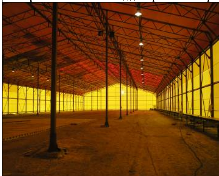
Тентовый склад размерами 26,7x130x6,5 в Воронежской области (вид изнутри и вид снаружи).
