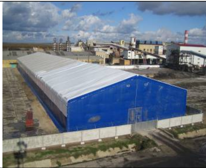
Комбинированный склад из профлиста и тента размерами 26,7x92x6,5 в Воронежской области.
