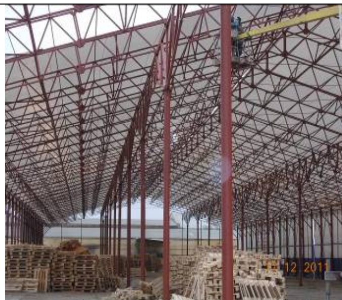
Каркасно-тентовый склад для хранения сахара размерами 32x172x6,5м. в Пензенской области.
